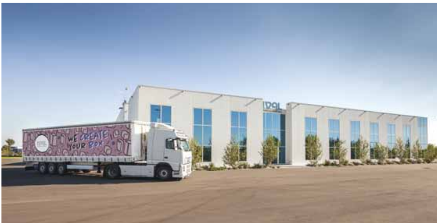
Lo stabilimento della litocartotecnica Ival
