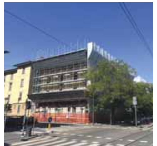
Lotto 2 - Intervento di recupero delle corti di Via Solari 40 a Milano
